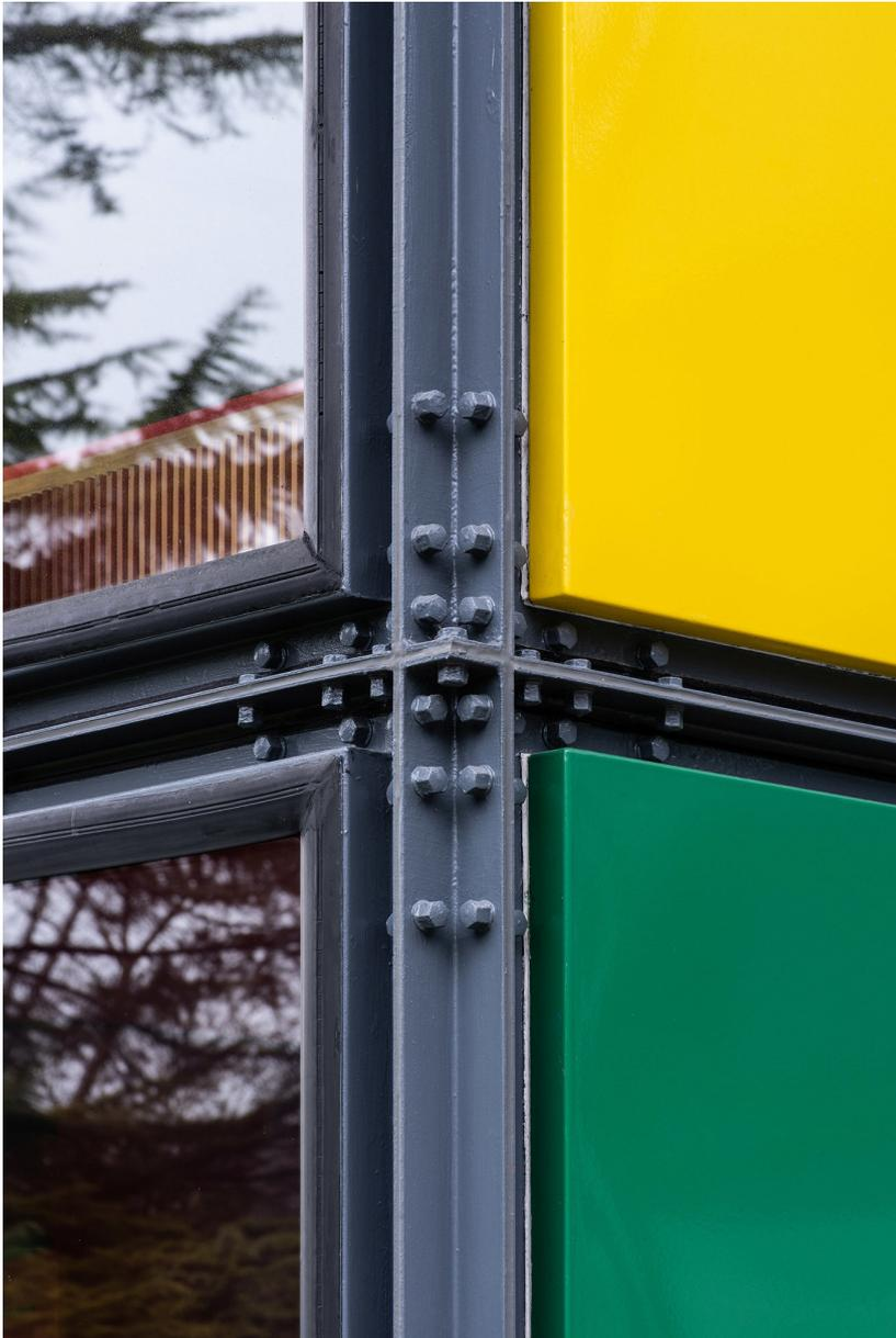
Für die Fassadenkonstruktion rief Le Corbusier den Ingenieur Jean Prouvé (1901–1984) zu Hilfe. Prouvé hatte bereits Erfahrung mit emaillierten Metallpaneelen. Er war es also, der eine Verglasung mit den im Fahrzeugbau üblichen Neopren-Profilen vorschlägt – Profile, die er beispielsweise am Hochhaus Tour Nobel (heute Tour Initiale genannt) in Paris in grossem Masstab eingesetzt hatte.
